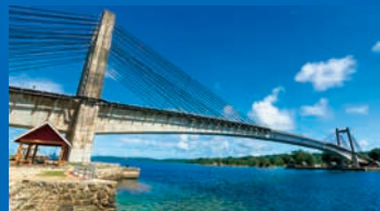
日本・パラオ友好の橋(パラオ)
